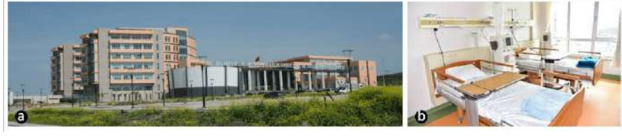
Şekil 4. (a) Bahkessir Üniversitesi Tıp Fakültesi güney cephesi, (b) Hasta odası iç mekanı.
